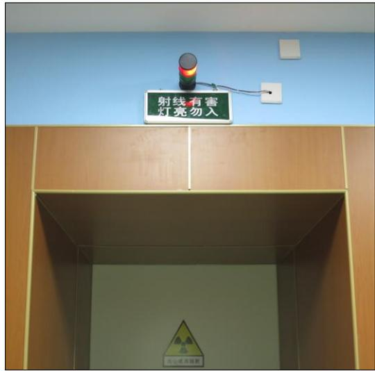
图 3 工作声光报警装置
